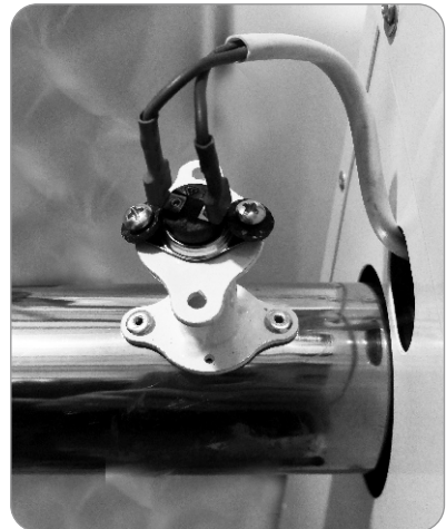
Рис. 3. Установка датчика тяги.
